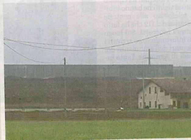
La barriera, alta complessivamente 11 metri, attorno alla fabbrica
