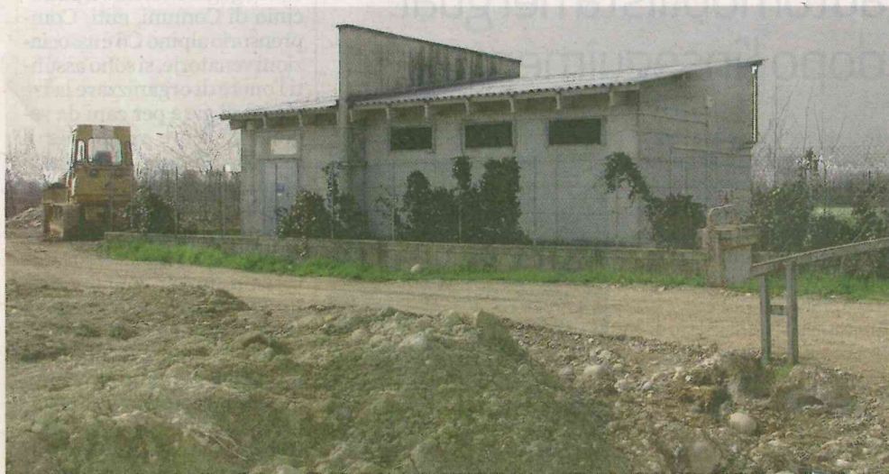
L'ex discarica della Vallosa, a Passirano: può finalmente scattare la rimozione dei numerosi fusti di Pcb
