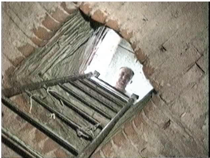
Rivediamo lassù l'ingresso del pozzo
