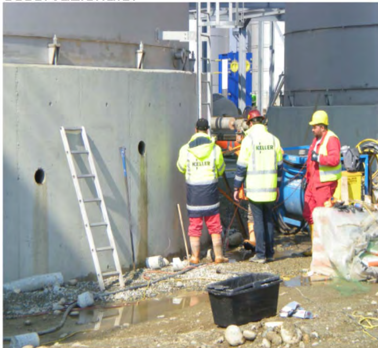
Esecuzione delle perforazioni per la realizzazione delle iniezioni di compensazione
