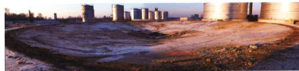
Fig. 1 - Fotografia del piano di appoggio del serbatoio TK 3104 dopo la rimozione del serbatoio danneggiato.
