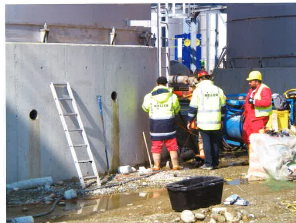
Fig. 17 - Esecuzione delle perforazioni per la realizzazione delle iniezioni di compensazione.
